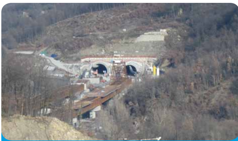
Nella foto la galleria Val di Sambro in costruzione
