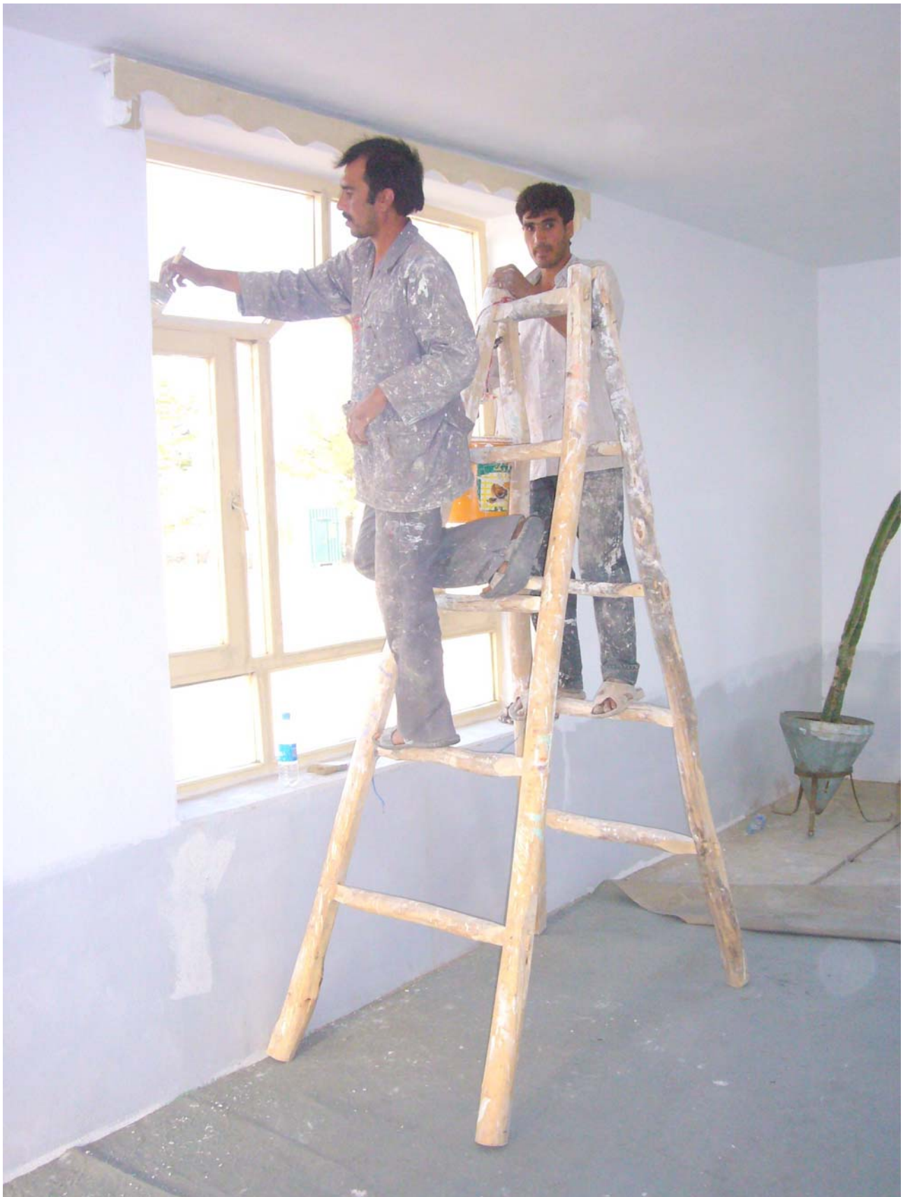
Herat (Afghanistan) – imbianchini al lavoro in un fabbricato di nuova costruzione
