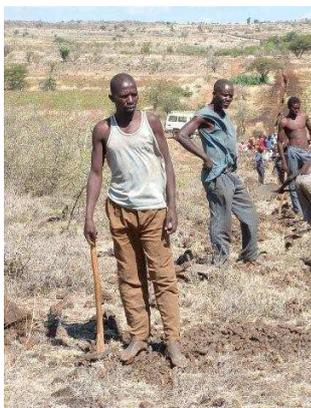
Nel cantiere vi erano due opere in corso di realizzazione: il completamento dell'acquedotto e la costruzione degli uffici del KKWP. Lo scavo della trincea per la posa delle tubazioni veniva effettuato manualmente da volontari dei villaggi e successivamente gli operai del KKWP posavano le tubazioni. La costruzione degli uffici da me diretta, era invece più assimilabile ad un cantiere edile tradizionale. Erano stati assunti degli operai a termine
