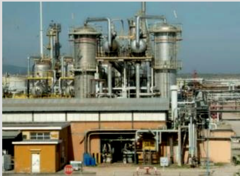
Impianto di produzione CVM – PVC di Porto Torres
